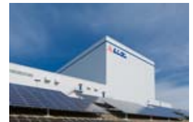
レンゴー株式会社 新名古屋工場 免震自動倉庫
